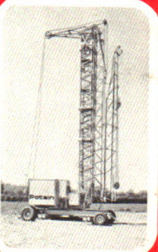
Dépliage de flèche dans 2 plans (Breveté)
